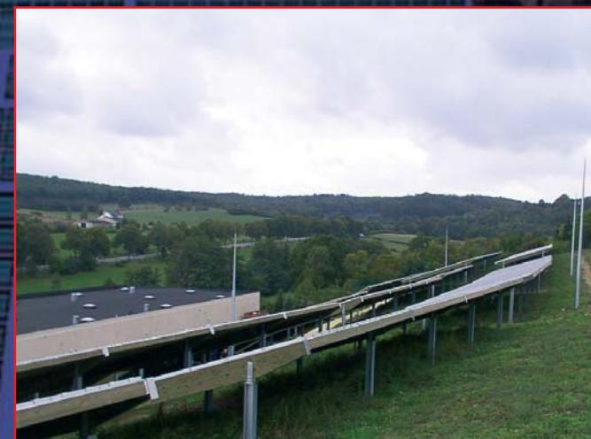
Alle Generatorgestelle werden mit einem Banderder untereinander verbunden. Zusätzlich werden diese strahlenförmigen Erder zu Maschen geschlossen.
