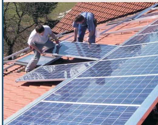
▶ Modulschiene mit Halteklammer auf Trägerschiene montiert. Endplatte und Abdeckschiene für Kabelschacht.
