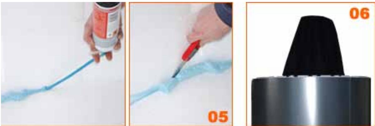
Nach einer Trockenzeit von ca. 25 Minuten muss der überstehende Schaum entfernt werden und der Boden von Verunreinigungen gesäubert werden – im Optimalfall mit einem Staubsauger.
